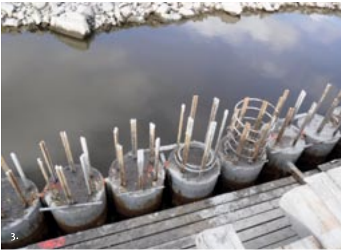
Kuva 2: Tässä vaiheessa rantamuurin palkin alaosa on jo valettu. Kuvassa näkyvät kallioankkurin punokset. Kallioankkureissa on 19 punosta dywidag-jänneteräksiä ja niiden koevetovoima on noin 3,9 MN.
