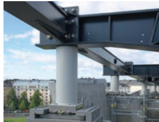
Vuoden Teräsrakenne 2019 olivat Olympiastadionin uudet katokset, joissa on järeät ja vaativat teräsrakenteet.
