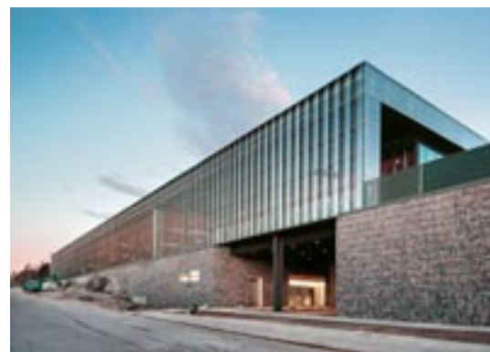
Vuoden 2013 teräsrakenne oli Siilitien metroasema.
