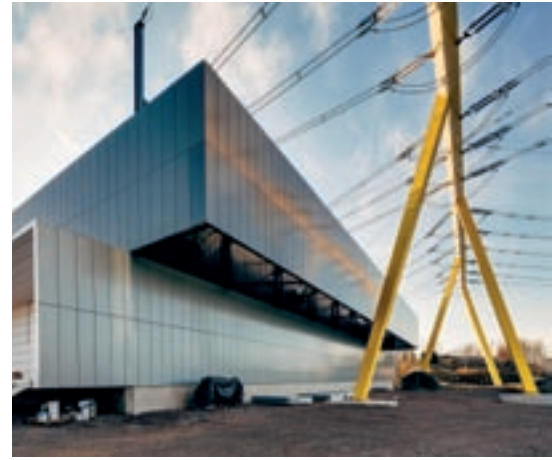
Vuoden 2014 Teräsrakenne Viikinmäen voimajohdtopylväs.
