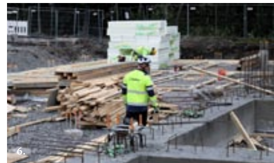
Kuvat 3–6: Peikolla on Konalan pelastusaseman työmaalla tähän asti laajin betonitöihin liittyvä urakka. Peikko vastaa nyt itse paikallavalutöistä ja siihen liittyvien mm. peruspulttien asentamisesta. Kun anturat oli jo valettu, olivat vuorossa pohjan valua valmistavat työt.
