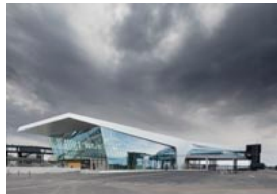
Länsiterminali 2 Vuoden Teräsrakenne 2017.
