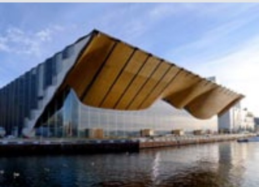
Kilden Norja, Vuoden Teräsrakenne 2011.
