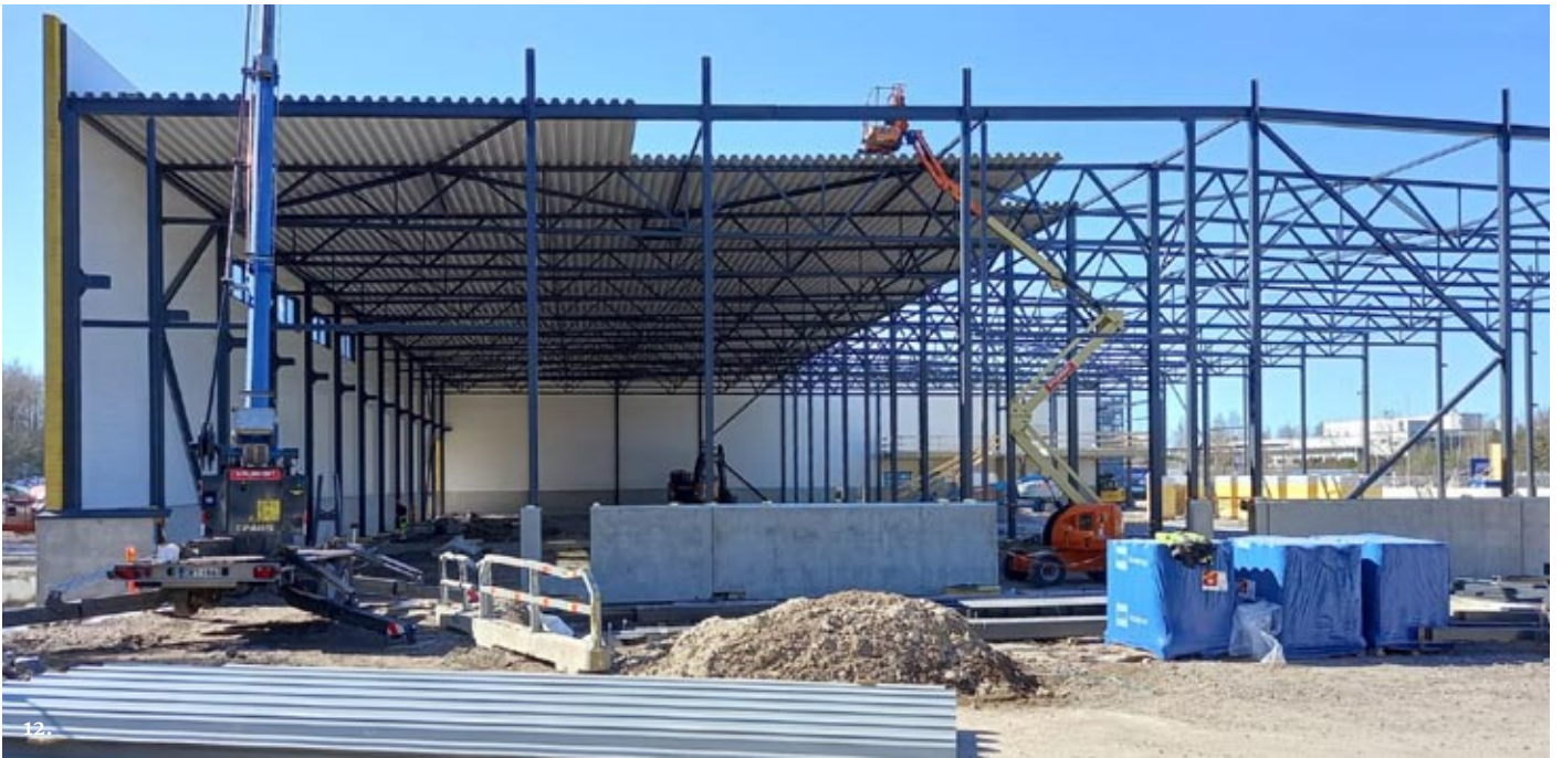
Kuva 10: Rakennuksen teräsrunko.
