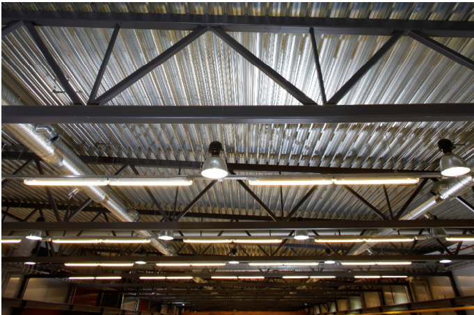
Kuva 3 Kantava teräskattoprofiili.
