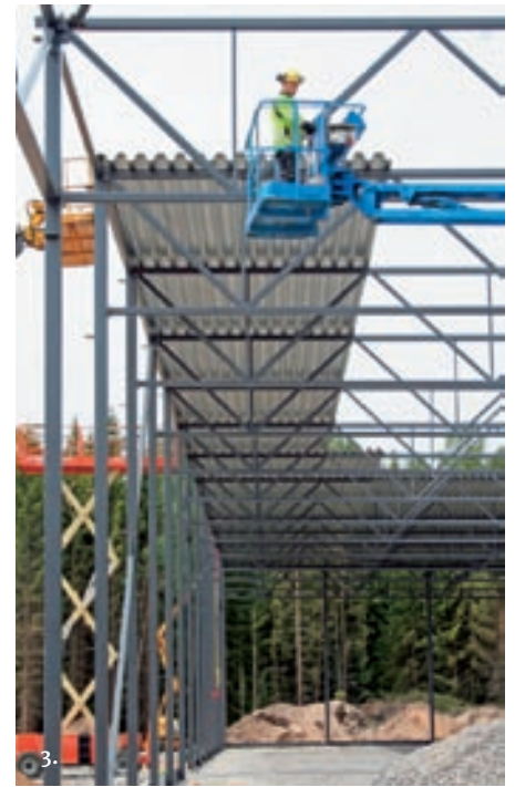
Kuva 3: Rungon pystytystyö oli kesäkuun puolenvälin lähellä jo pitkällä. Kirkkaan oranssiseksi maalatut keskipilarit helpottavat törmäysten välttämistä veneitä sisällä siirrettäessä.
