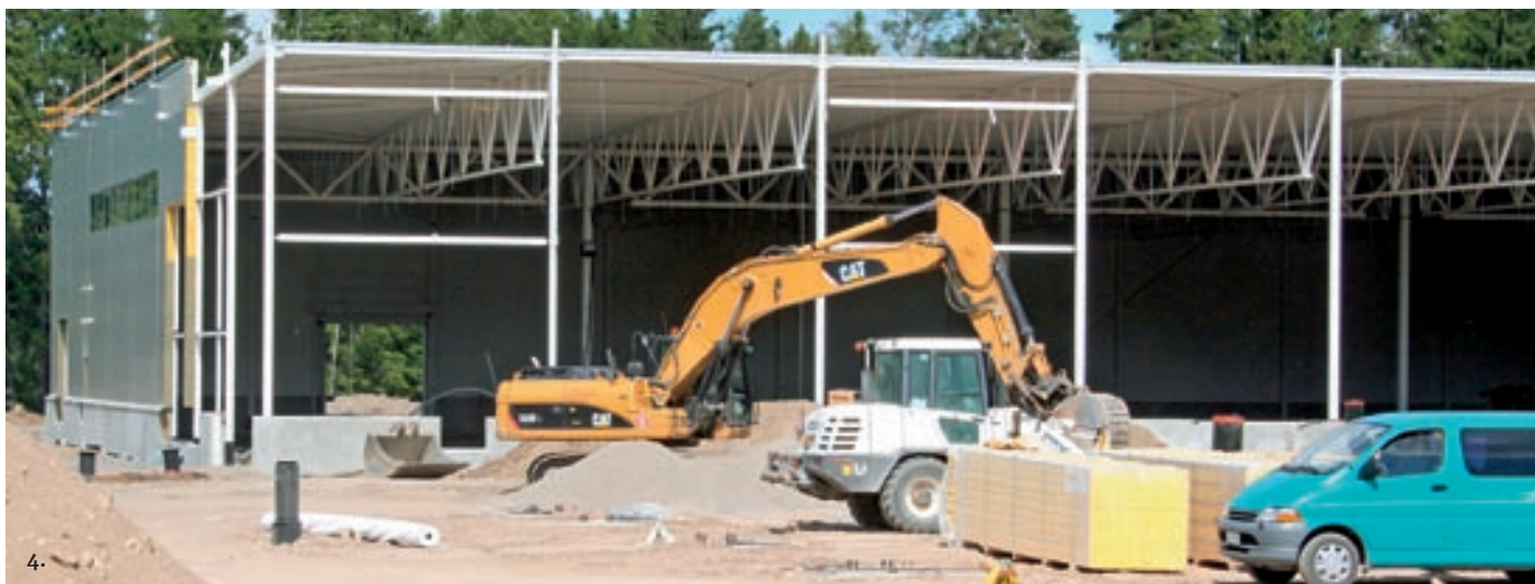
Kuva 3,5,8: K-Raudan rakenteita elo-syyskuun 2015 vaihteessa.
