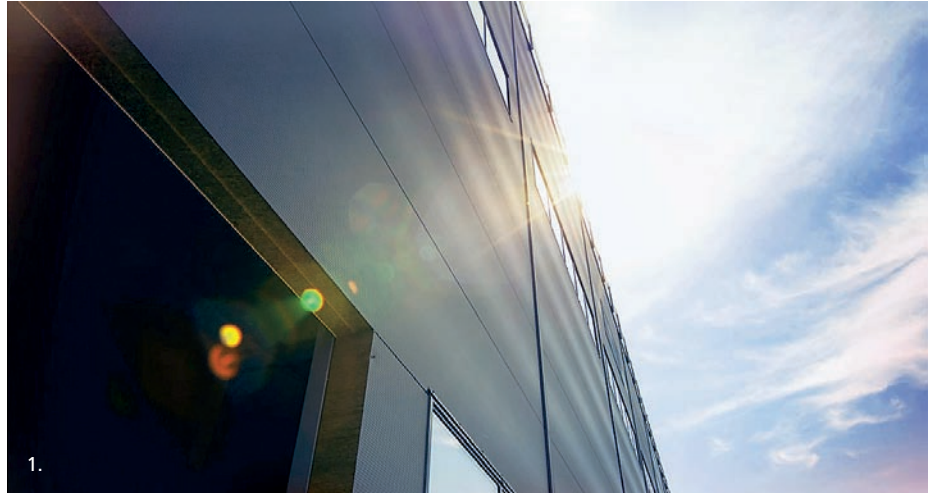
Kuva 1: Hiarc reflect on auringon lämpösäteilyä heijastava julkisivupinnoite, joka heijastaa takaisin osan auringon lämpösäteilyä ja pitää paneelin pinnan viileämpänä. Hiarc reflect soveltuu sandwich-paneelien ulkopinnoitteeksi, ja eristämättömissä rakennuksissa sitä voidaan käyttää profiileissa.
