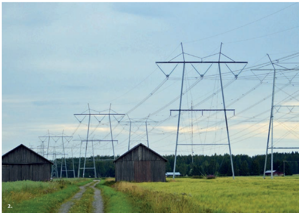
Kuva 1: Aurajoki Oy:n valmistama putkijalkapylväs.
